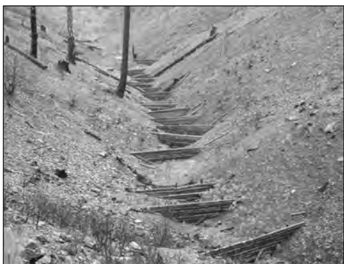
Εικόνες 3α και β. Σειρά ξυλοφραγμάτων (α) και συγκράτηση φερτών υλών (β) στο δάσος Ταϋγέτου.
