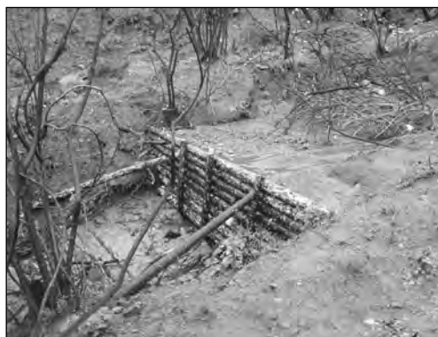
Εικόνες 3α και β. Σειρά ξυλοφραγμάτων (α) και συγκράτηση φερτών υλών (β) στο δάσος Ταϋγέτου.
