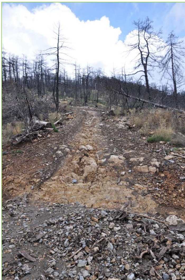
Εικόνα 6. Αύξηση της επιφανειακής και αυλακωτής διάβρωσης κατά μήκος τρακτερόδρομου στον Πάρνωννα.
